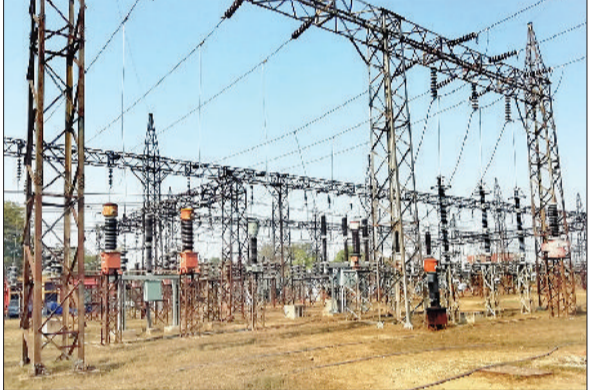
नारनौल। निर्माणाधीन विद्युत सब स्टेशन
